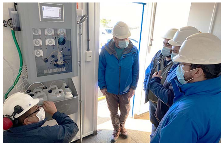
Mise en service et réception des analyseurs Topaz Fer et Manganèse client pour le contrôle du produit final chez le client.
